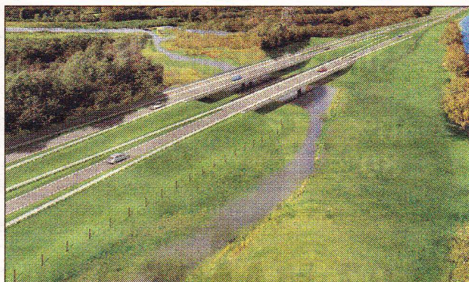
De verbinding van bovenaf gezien. (Foto: Provincie Noord-Holland)
